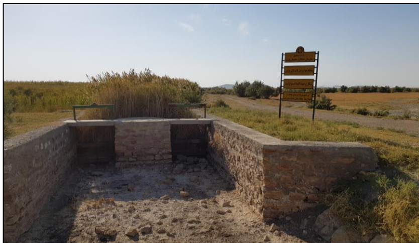
تصویر شماره ۱۱-۱۲۳: نمونه‌ای از سازه زهکش و دریچه کنترل آب
