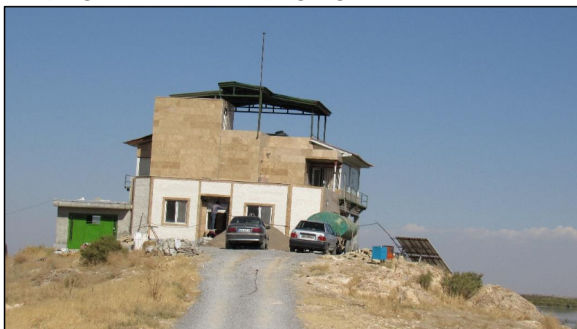
تصویر شماره ۲۱-۱۱۲: ساختمان حفاظت و پرنده نگری واقع در لبه غربی تالاب کانی برازان
