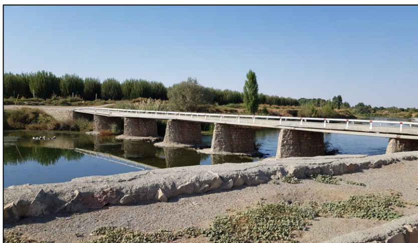
تصویر شماره ۲۰-۱۲۳: پل رود مهابادچای در روستای خورخوره
