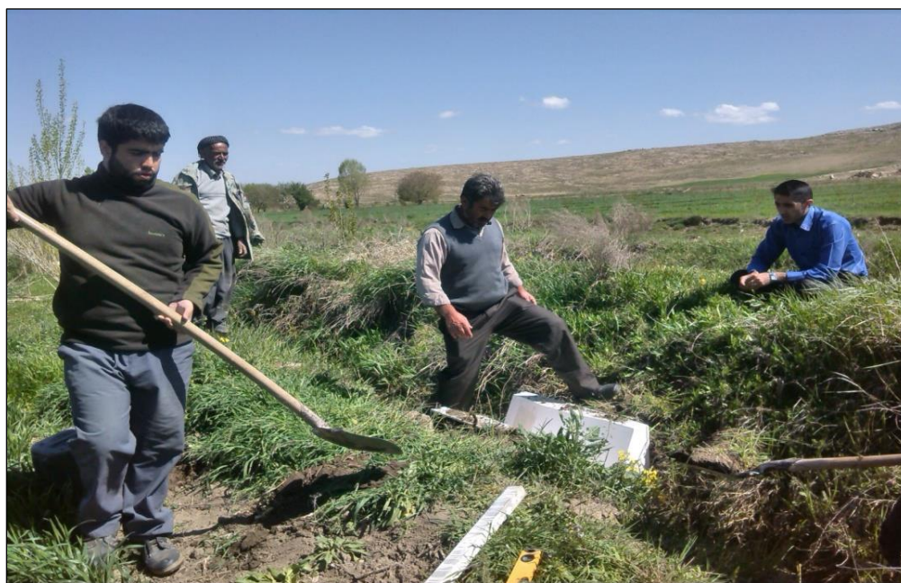
شکل ۳-۱۳- نصب فلوم تیپ ۴ در مزرعه آقای رحمانزاده - روستای خورخوره‌ی مهاباد
